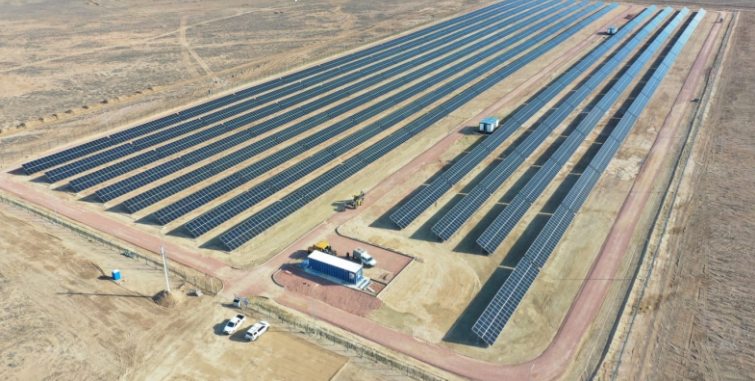
Новая солнечная электростанция мощностью 4,77 МВт, Балхаш
