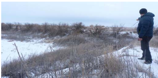
Рисунок 1 – Действующий Бугут №1, гребень земляной плотины.
