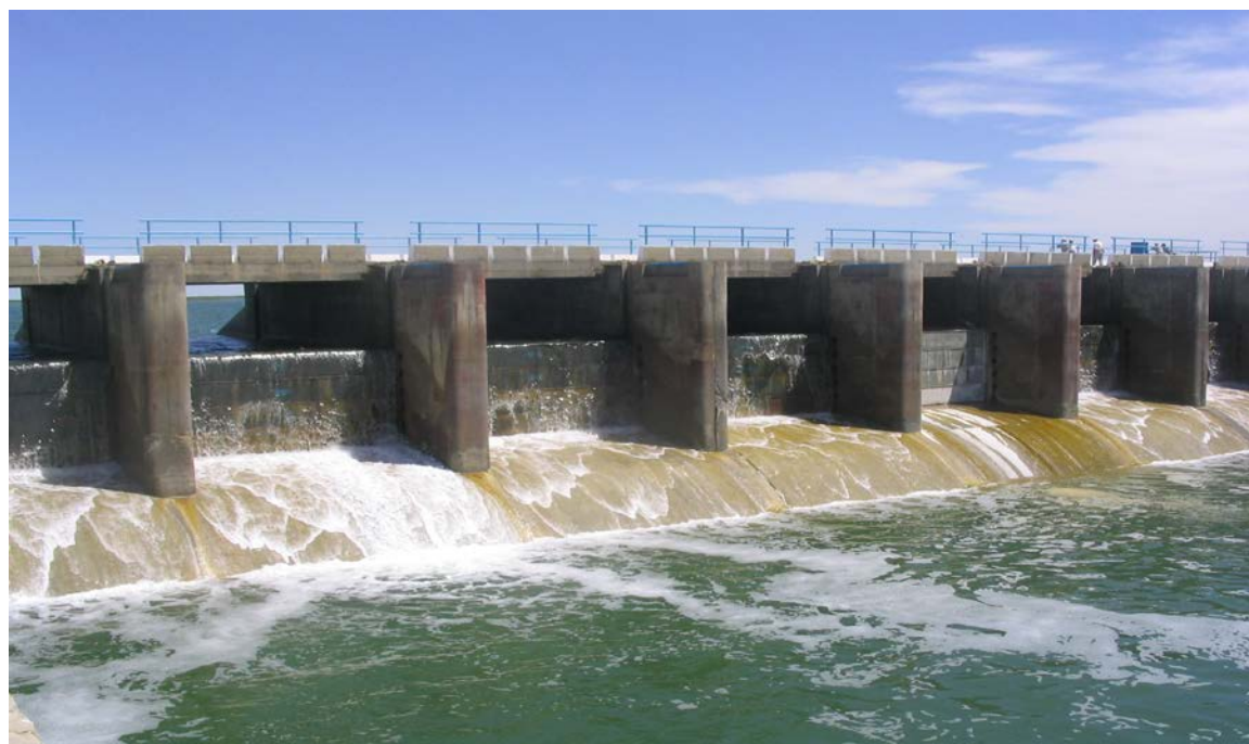
Рис.П2. Водосбросное сооружение на плотине САМ.
