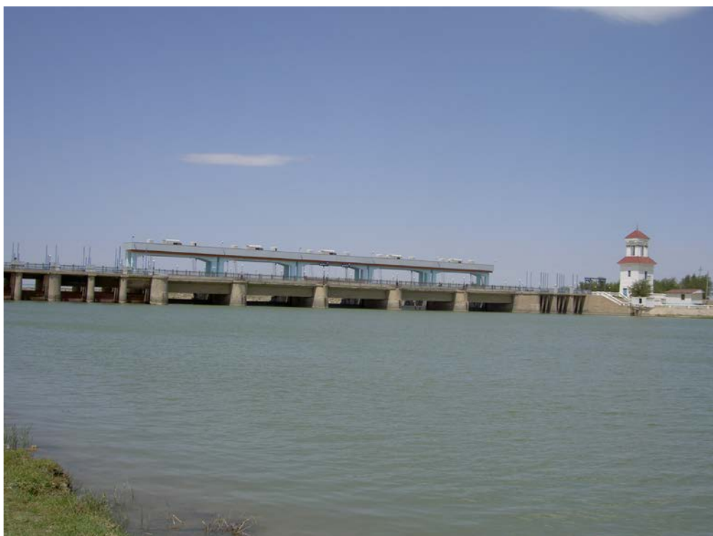
Рис. П8. Кызылординский гидроузел (верхний бьеф).
