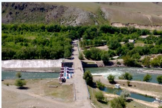
Рисунок 2 - Общий вид гидроузла сверху
