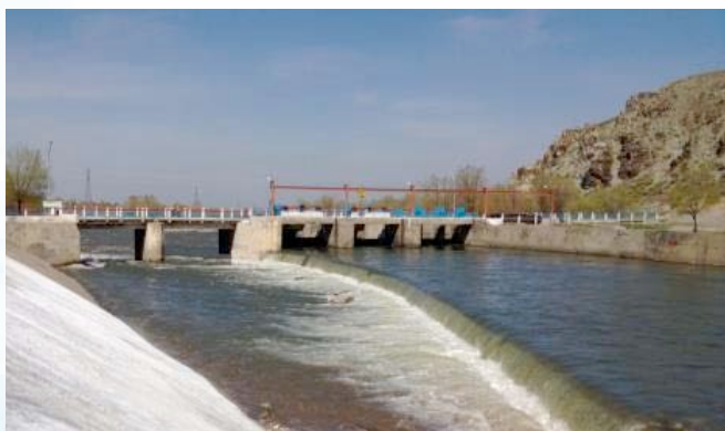
Рисунок 1 - Общий вид гидроузла с верхнего бьефа
