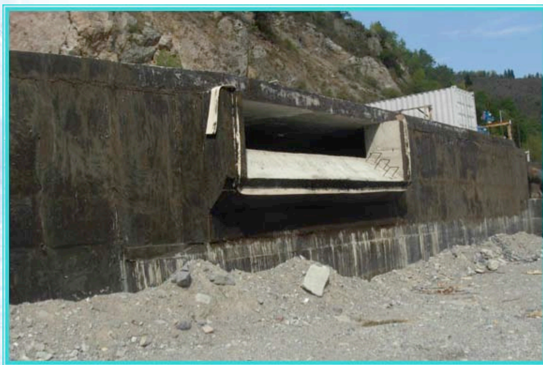
Рис.2 Вид железобетонного отстойника ГЭС на реке Иссык в период его строительства (2008)
