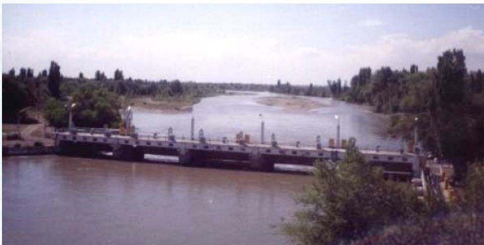
Каратальская щитовая плотина – первая крупнейшая в Казахстане – построена в 1940 году для забора воды на орошение плантаций риса и сахарной свеклы
