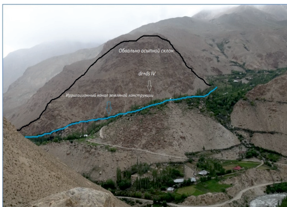
Рис. 19. Обвальнo-осыпной склон (LS -6) на участке 2 у кишлака Миденшарв. Фото О.Н. Мавлоназарова
