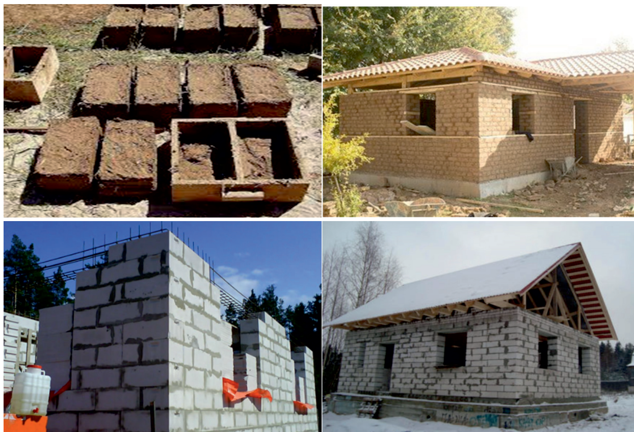
Рисунок 1. Строительство здания из глиносаманных и газобетонных блоков
