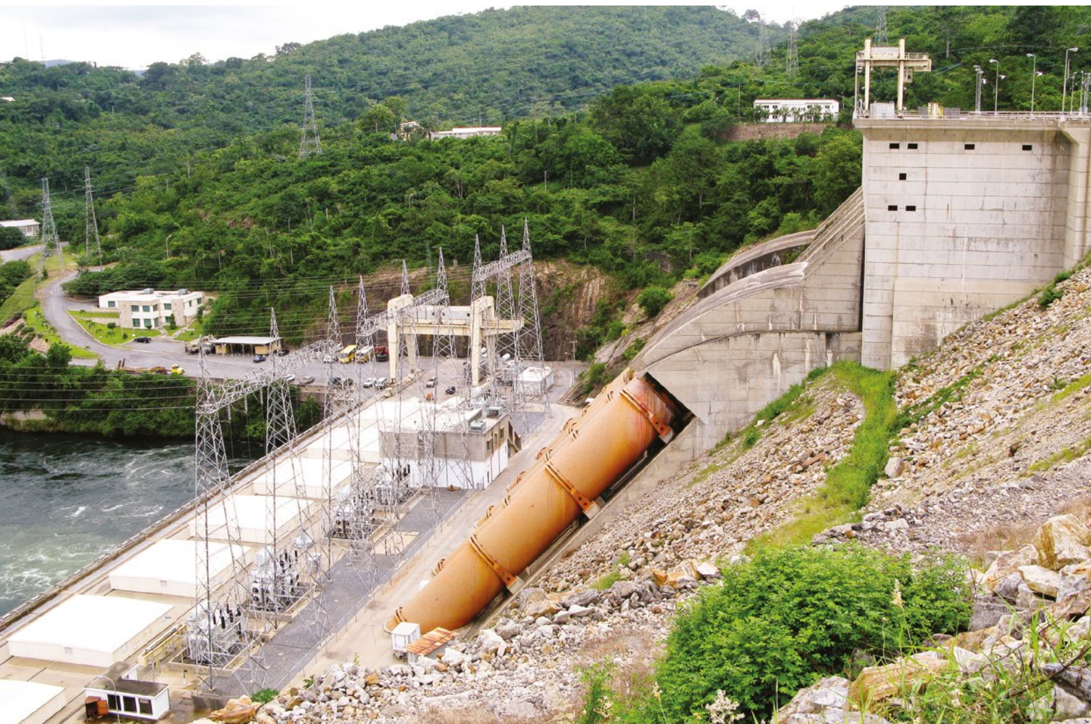
Гидроэлектростанция в Гане
