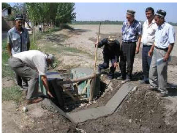
Рис. 1 - а) Участие членов АВП в строительстве гидропостов; б) Завершенный гидропост - лоток САНИИРИ
