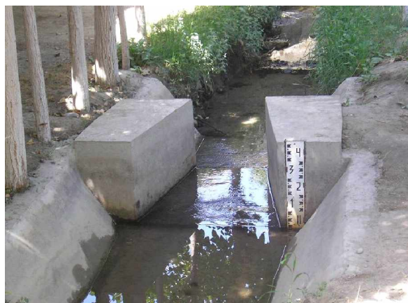
Рис. 1 - а) Участие членов АВП в строительстве гидропостов; б) Завершенный гидропост - лоток САНИИРИ
