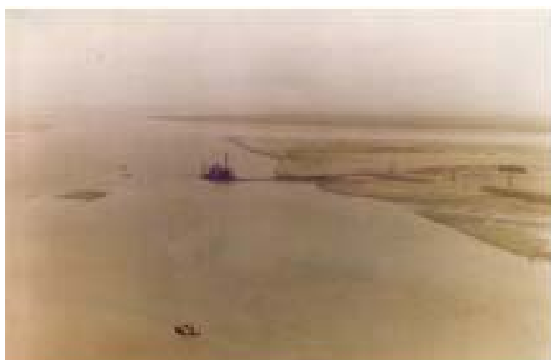
Фото 1 Дноуглубительные и очистные работы на правобережной протоке выше головного водозабора Каршинского магистрального канала, земснарядом 444
