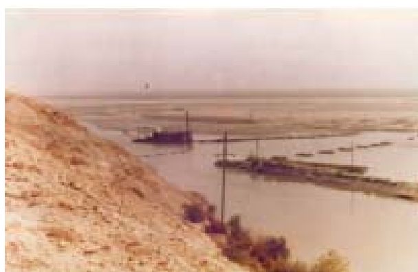
Фото 2 Земснаряд производит очистные работы перед водозабором на входе Каршинского магистрального канала
