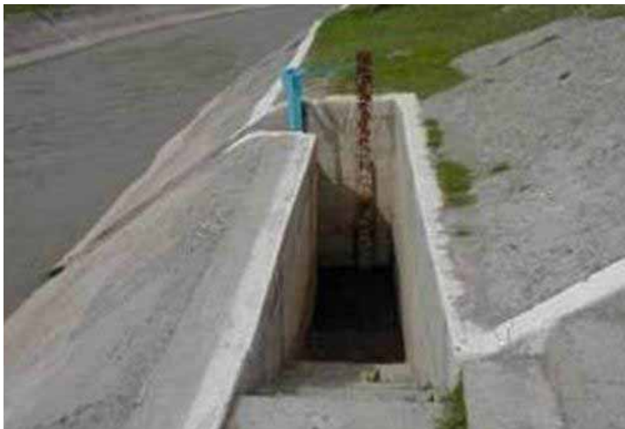
Рис. 2. Успокоительный колодец с уровнерной рейкой на гидрометрическом посту магистрального канала
