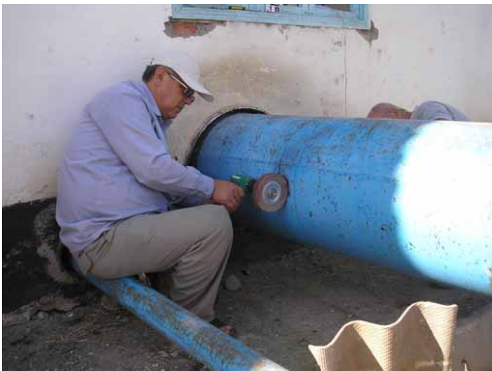
Очистка места установки накладных ультразвуковых датчиков
