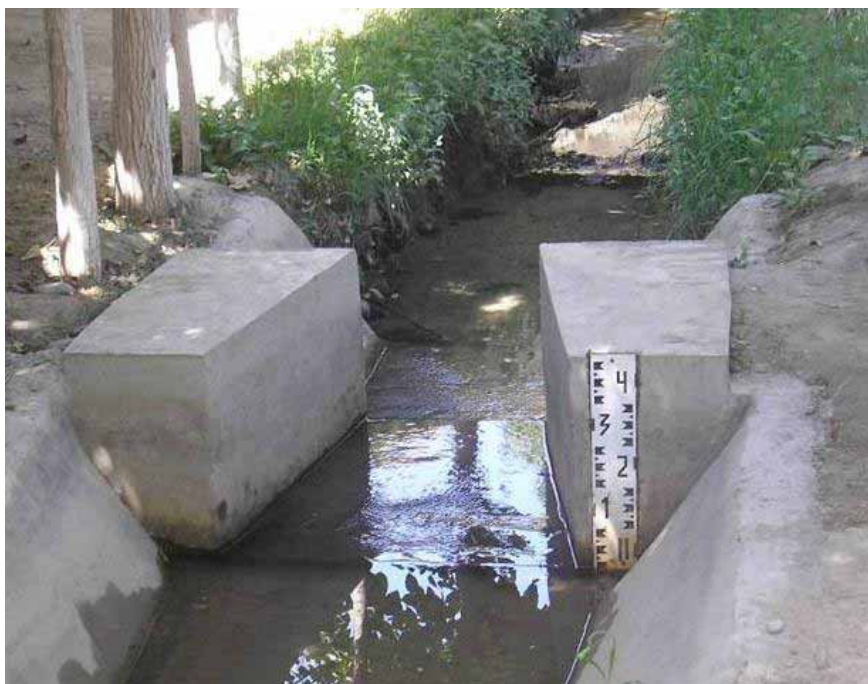
Рис. 5. Водомерный лоток САНИИРИ
