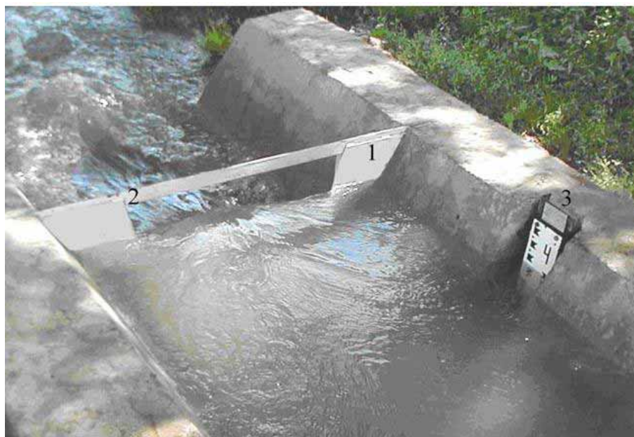
Рис. 4. Трапециевидальный водослив
