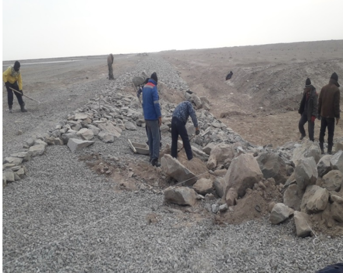
Реконструкция дамбы дороги вдоль озера Майпост
