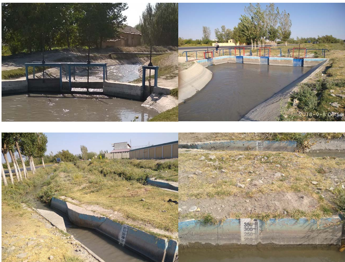
Рис. 1. Регулирующие сооружения и гидросты в голове отводов в ОВП
