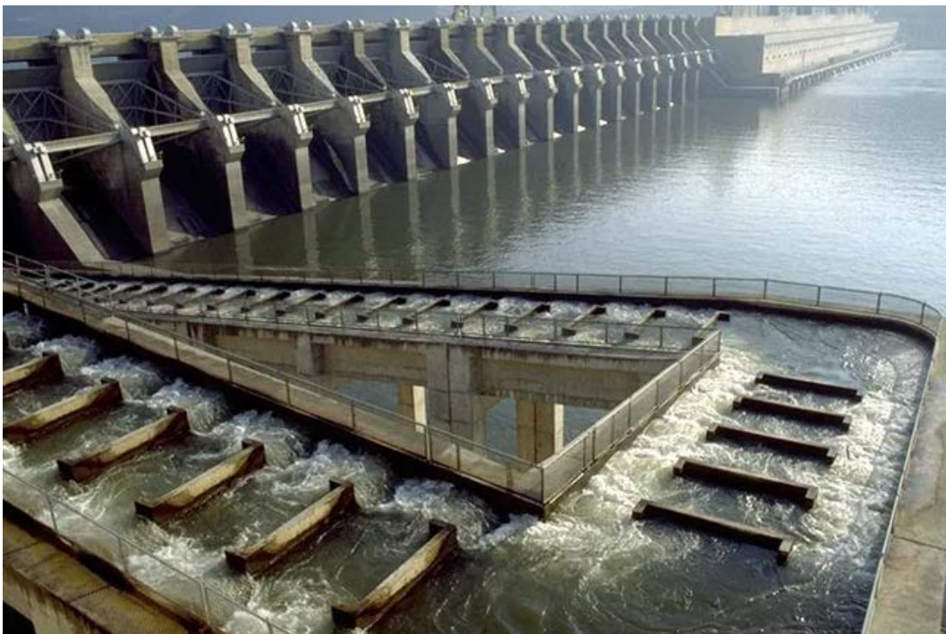
Рыбоход плотины Джона Дя на реке Колумбия, США
