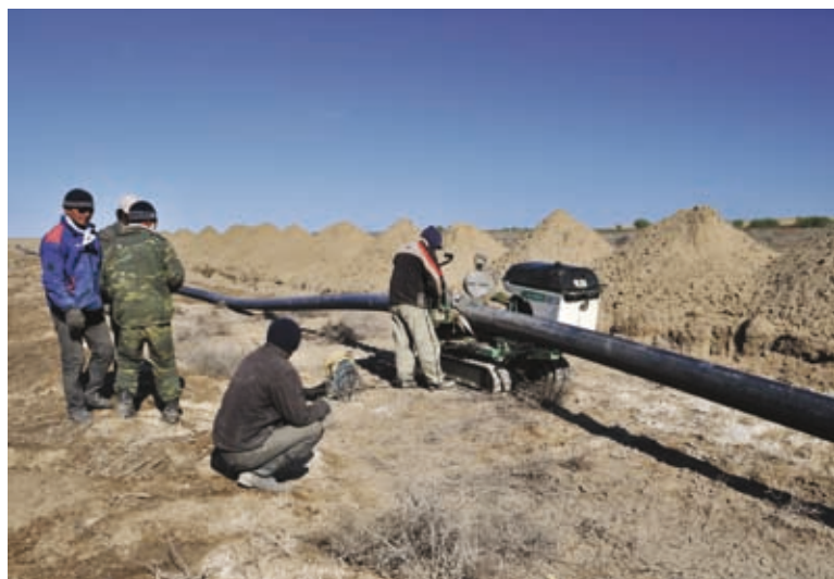
Реконструкция Жиделинского группового водопровода апрель, 2010
