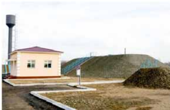
Резервуар для воды объемом 50 м 3
