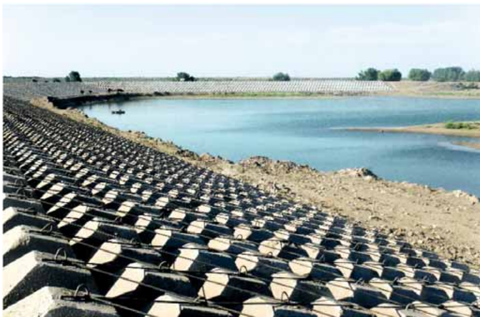
Крепление верхового откоса Северной дамбы Междуреченского водохранилища из тетраэдрных блоков
