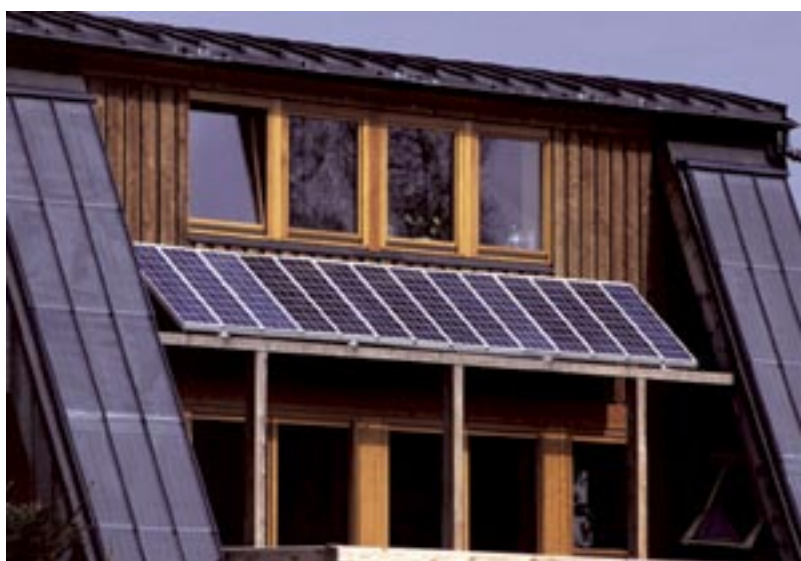
Рис. 7. Солнечные батареи на крышах домов
