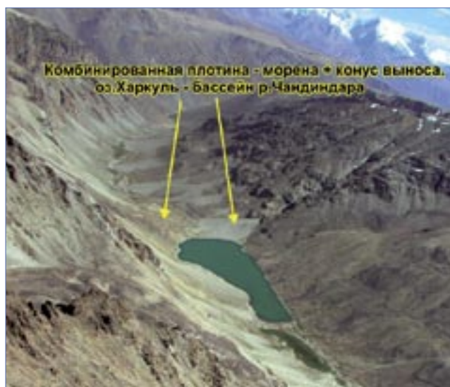
Фото 20. Композитная перемычка на оз.Харкуль
