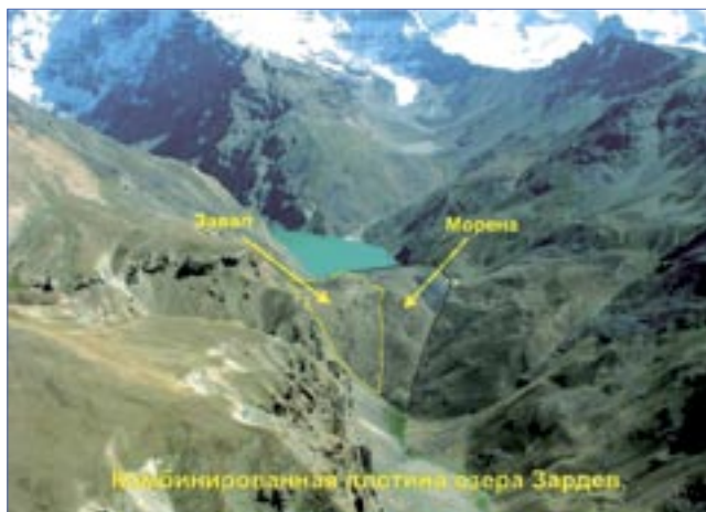
Фото 16. Композитная перемычка на оз.Зардев
