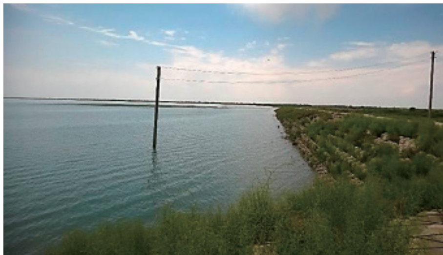
Фото 2.6. Северная дамба Междуреченского водохранилища, май 2017 г. (фото В.Соколова)
