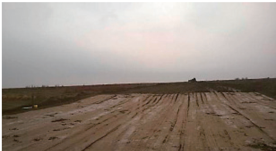
Фото. 2.7. Строительство восточной дамбы Междуреченского водохранилища, март 2017 г. (фото: В. Соколова)
