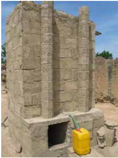
Рис. 6. Мочеотводящий туалет Буркина Фасо. Фото: Элизабет Кварнштрём (Elisabeth Kvarnström).
