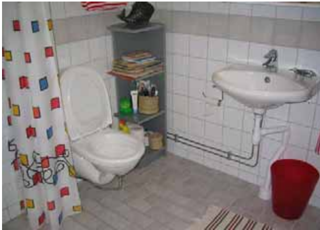
Рис. 5. Туалет с мочеотводящей системой, Г. Куллон, Швеция Фото: Рон Савьер (Ron Sawyer).
