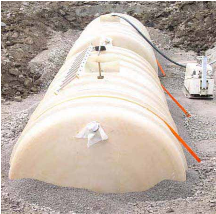
Рисунок 19. На рисунке показан период строительства емкости по сбору мочи в г. Куллон. Емкость должна быть засыпана землей. Фото: Мац Йоханссон.
