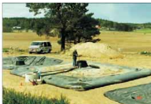
Рисунки 8 и 9. Сбор и хранение урины может осуществляться в различных масштабах. Когда при сборе урины применяются большие резервуары или резервуары хранения урины на полях (как на этих рисунках), необходимы более высокий уровень безопасности и более жесткие рекомендации относительно хранения материала, выделенного различными людьми.
