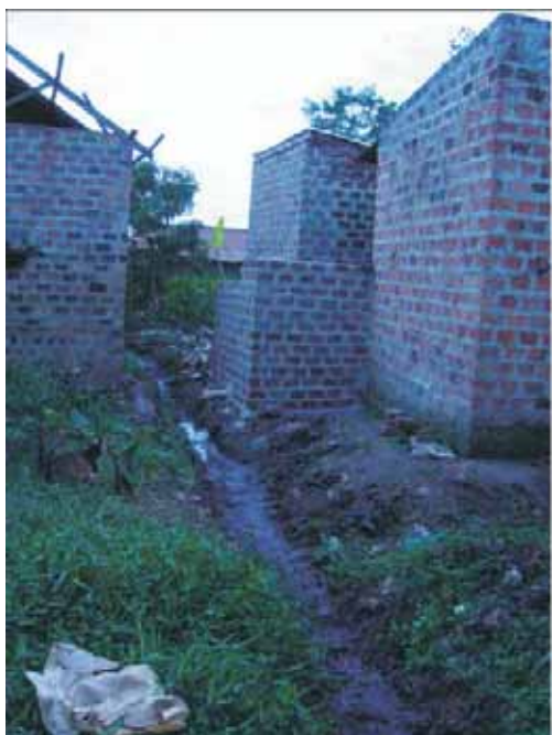
Рисунок 4. Содержимое из обычных вырытых уборных или безводных уборных никогда нельзя изымать и сливать в дренажные каналы. Загрязнение путем попадания фекалий человека в дренажные отводы для ливневых вод – основной риск передачи кишечных и паразитических заболеваний.
