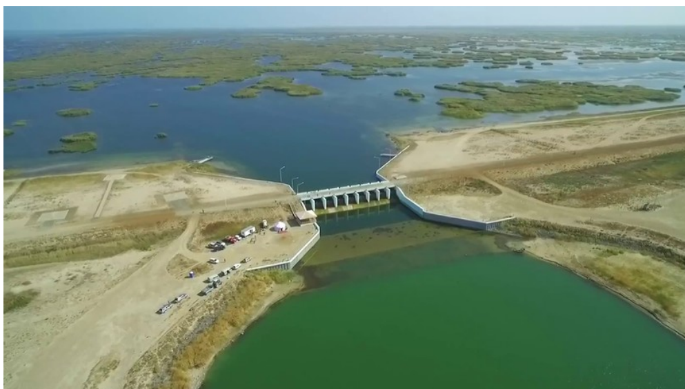
Кокаральская плотина с регулирующим сооружением (вид с юга)
