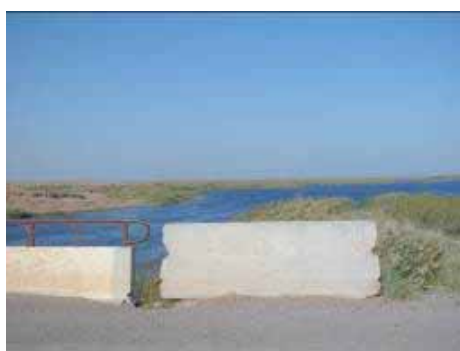
Рис. 3.3 Центральный Голодностепский коллектор (ЦГК)
