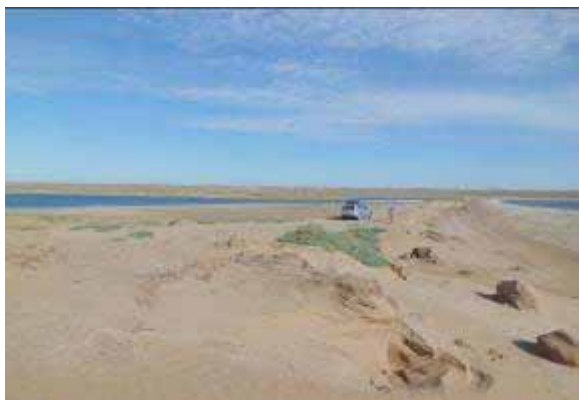
Рис. 1.2. Фрагмент разрушенной дамбы
