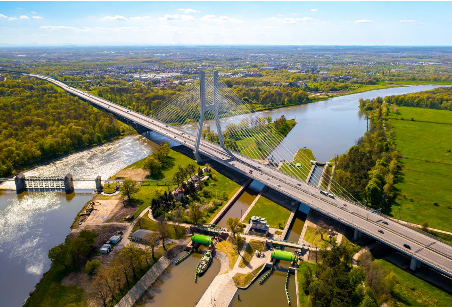
Redzinski Bridge over Oder River
