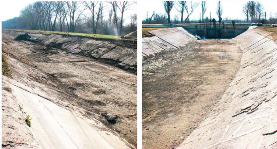
Фото 1,1. Ремонт участка канала Ингулецкой оросительной системы
