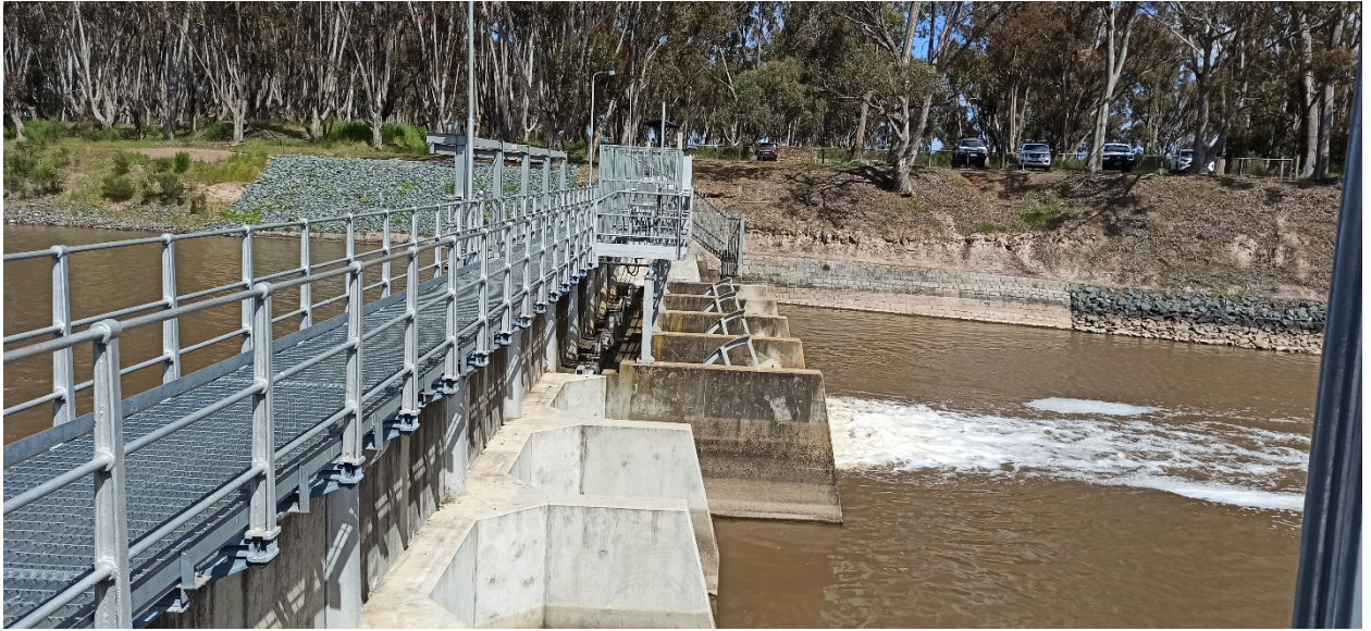
Гидроузел Гоулбарн (Goulburn weir) на реке Гоулберн (левый приток реки Муррей), штат Виктория, построенный в 1892 году. Последняя реконструкция проведена в 1997 году (установлена система SCADA компанией «Rubicon Water»). (фото В.Соколова 9 октября 2022 года)
