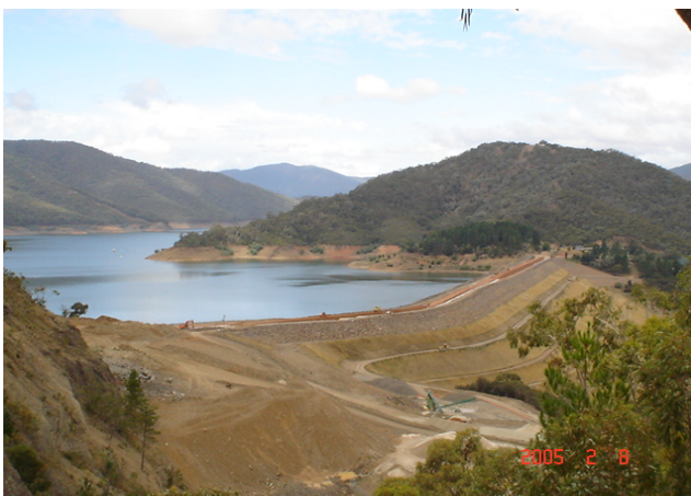
Водоохранилище Илдон (Eildon), штат Виктория объемом более 3 км 3 – на гребне шли работы по наращиванию плотины с целью повышения безопасности
