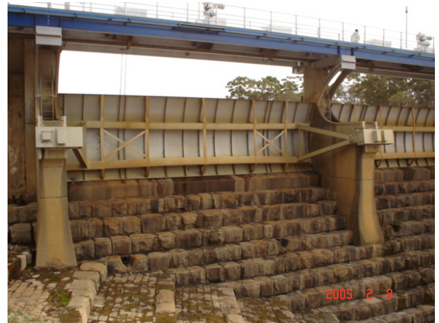
На фото: Затворы сооружения – вид с нижнего бьефа. Следует обратить внимание на качество стыков и уплотнителей, при полном напоре - практически отсутствуют протечки
