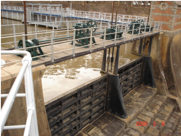
То же, в старой части сооружения, оснащенной шандорными щитами – протечки практически отсутствуют.
