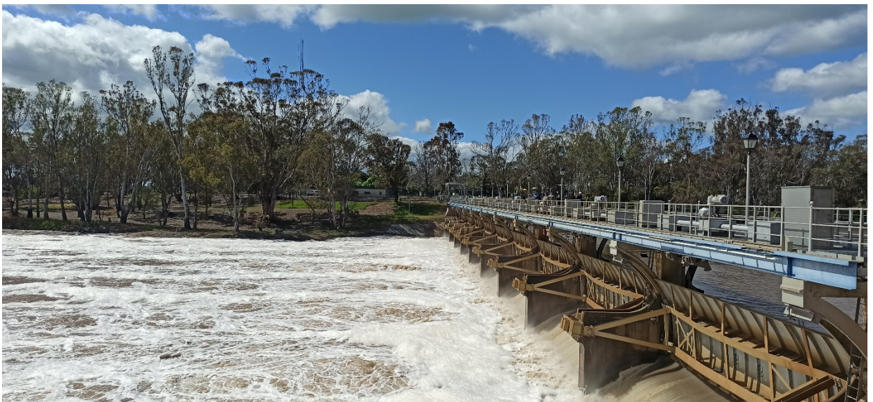
Гидроузел Гоулбарн (Goulburn weir) на реке Гоулберн (левый приток реки Муррей), штат Виктория, построенный в 1892 году. Последняя реконструкция проведена в 1997 году (установлена система SCADA компанией «Rubicon Water»). (фото В.Соколова 9 октября 2022 года)
