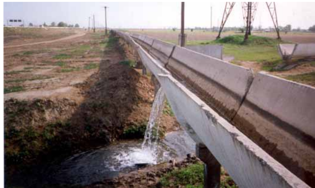
Большие потери воды из лотков. В данном случае лоток разбит для неконтролируемого забора воды - Сырдарья, Узбекистан
