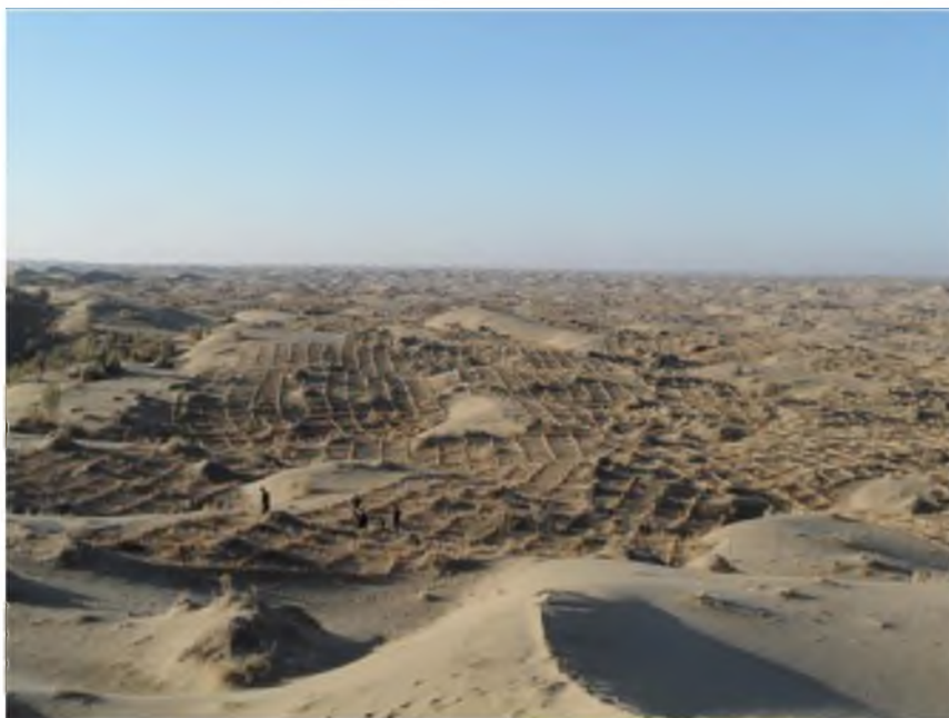
Рисунок 3 – Закрепление барханных песков механическими заплатами
