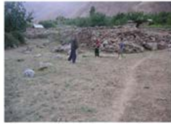
Очистка участка от камней
