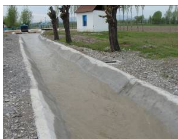
Створ гидропоста "Конурат" с урвнемерным колодезём после реконструкции НБ
