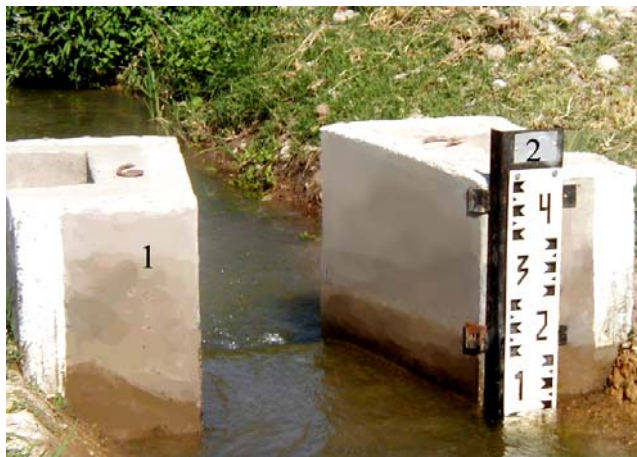
5 - Расм. САНИИРИ нинг сув ўлчаш нови, юқори бьеф томони. 1 - кириш қисми, 2 - гидрометрик рейка.
