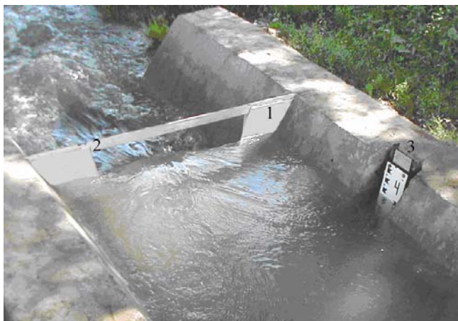
3 - расм. Чиполетти водосливи (юқори бьефдан кўриниши).
