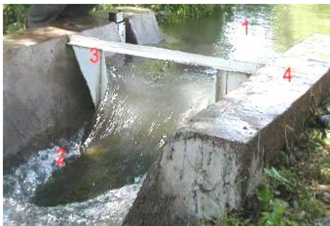
4 – расм. Чиполетти водосливи (пастки бьефдан кўриниш).
