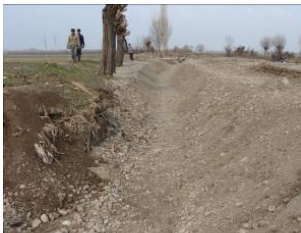
Рис. 6. Прокладка проектного профиля в грунте ВБ этап земляных работ
