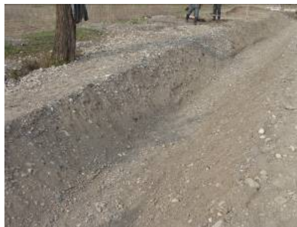
Готовый проектный профиль канала ВБ этап земляных работ
