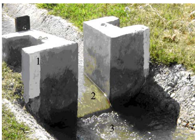
6 - Расм. САНИИРИ нинг сув ўлчаш нови, пастки бьеф томони. 1 - чиқиш қисми, 2 - новнинг туби, 3 - чуқурча, 4 - пастки бьефда канал ёнбағирларини маҳкамлаш.
