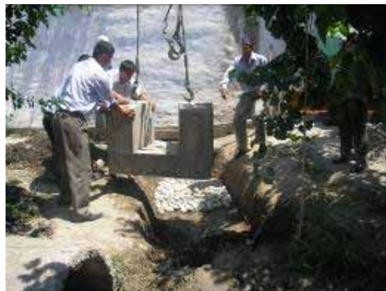
а) при помощи переносной опалубки б) монтаж лотка заводского изготовления Рис.4. Строительство гидростов с лотками "ВЛС".
