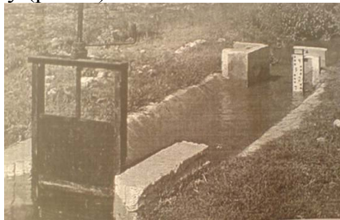
Рисунок 3. Гидрометрический пост, оборудованный лотком САНИИРИ.
