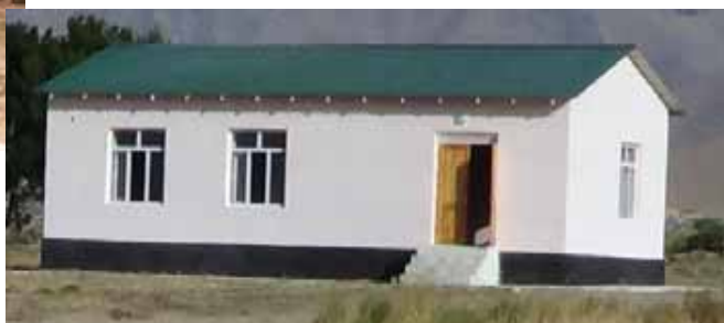
Процесс строительства Ресурсного центра
