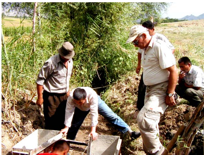
Рис.6. Установка металлической опалубки для отливки лотка САНИИРИ
