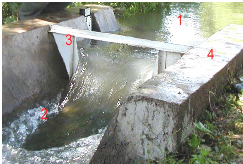
Рис.2. Водослив Чиполетти (вид с нижнего бьефа):
