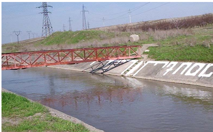
Рис.1. Гидрометрический пост типа «ФР» оборудованный гидрометрическим мостиком
