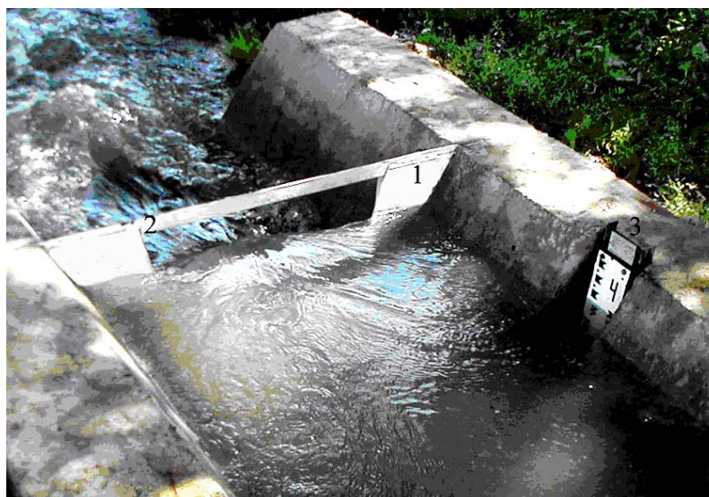
Рис. 1. Водослив Чиполетти (вид с верхнего бьефа): 1- водослив ВЧ-50; 2-ребро жесткости; 3-успокоительная ниша с уровнемерной рейкой.
