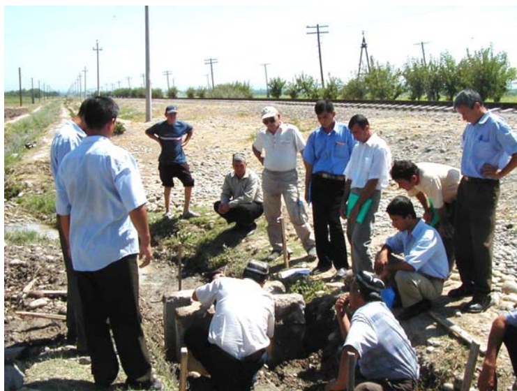
Рис. 5. Установка «ВЛС» заводского изготовления в створе гидропоста
