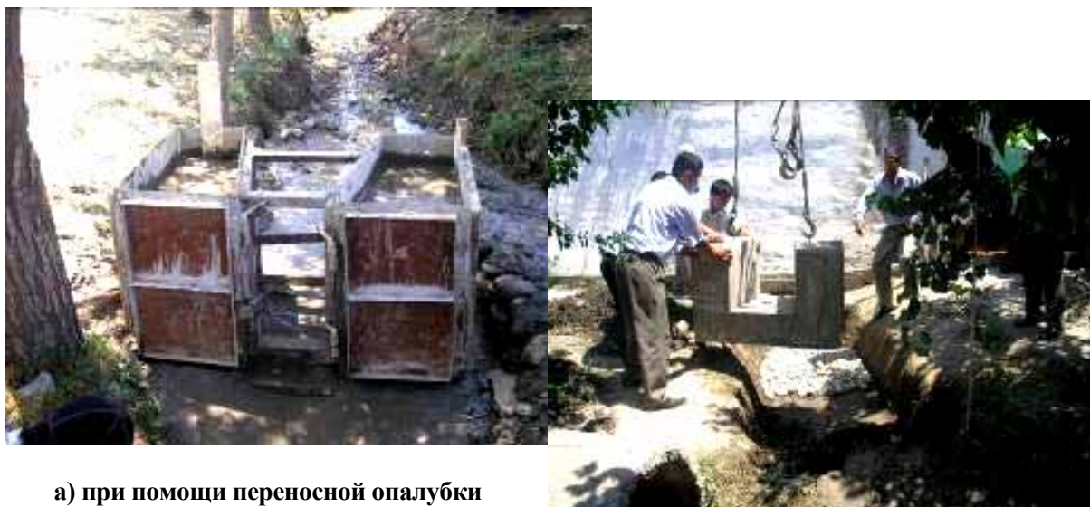
б) монтаж лотка заводского изготовления
