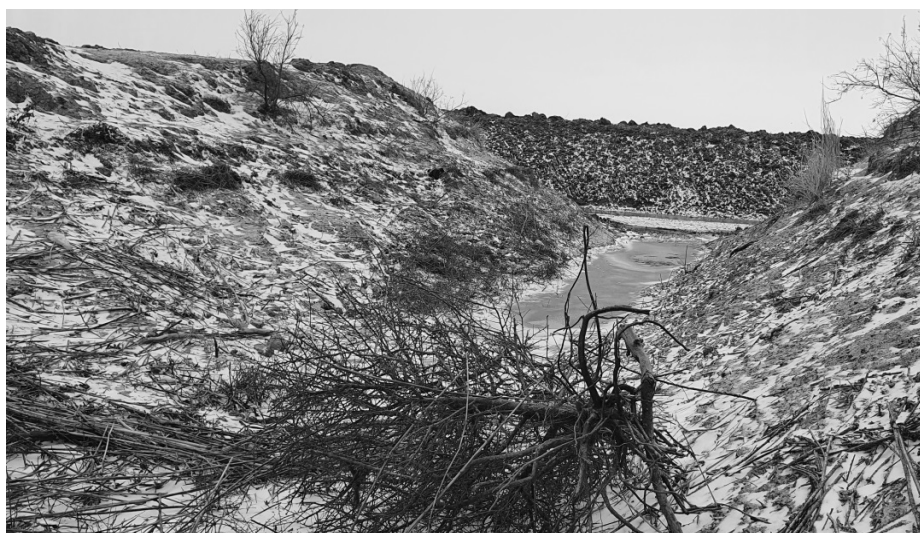
Рисунок 3 – Вид с бровки отводящего канала при соединении с Черноземельским магистральным каналом (фото В. Ф. Талалаева)
