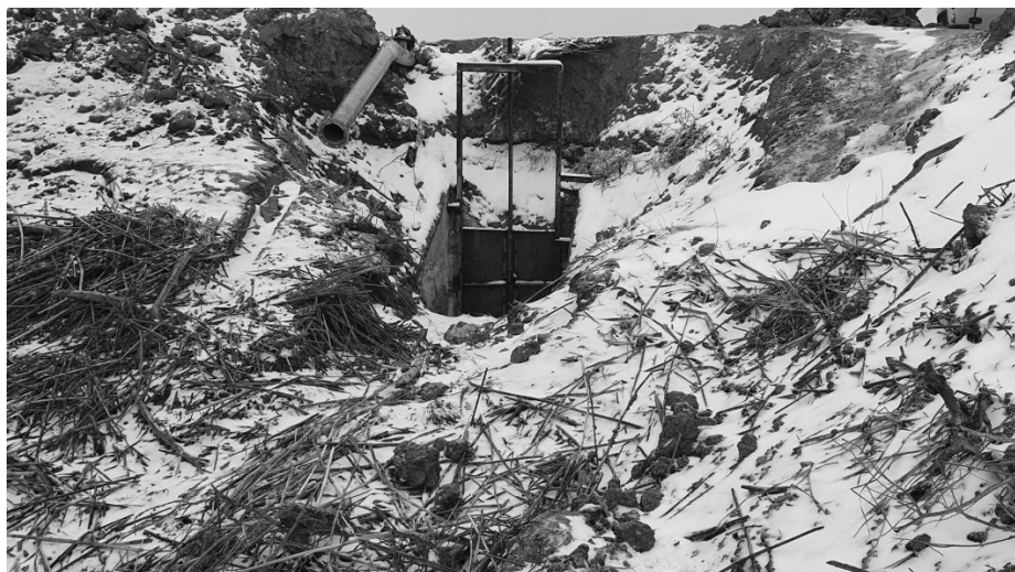
Рисунок 2 – Вид на приемную камеру со стороны верхнего бьефа (фото В. Ф. Талалаева)
