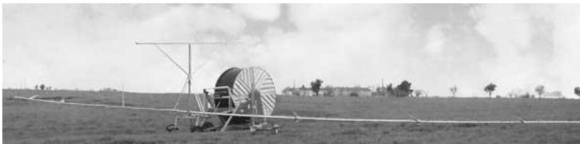
Рисунок 2 – Двухконсольный дождевальный распределительный трубопровод вантовой конструкции
