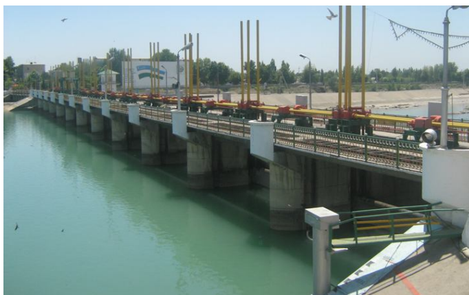
Рисунок 2 – Водосбросная плотина Учкурганского гидроузла (вид с верхнего бьефа)
