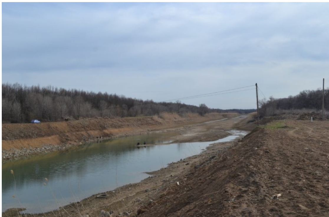
Рисунок 1 – Участок Донского магистрального канала в земляном русле (автор фото О. А. Баев)
