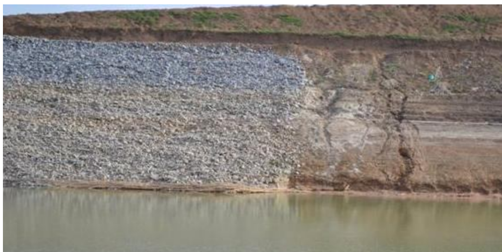
Рисунок 3 – Противофильтрационное покрытие с бентонитовыми матами на ДМК (автор фото О. А. Баев)
