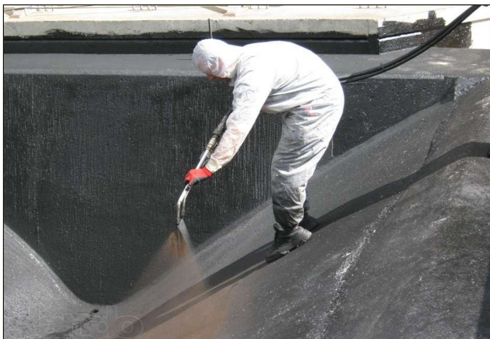
Рисунок 3 – Напыление жидкой резины на оросительном канале
