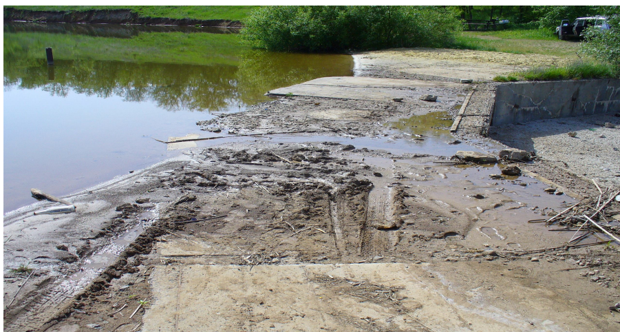
Рисунок 5 – Отмостка вокруг входного оголовка водосброса
