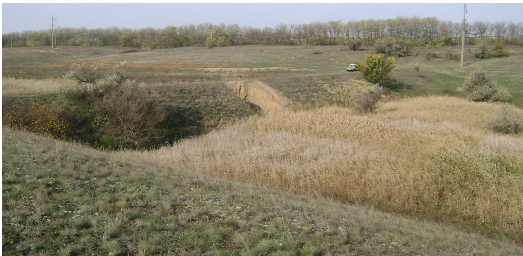
Рисунок 2 – Разрушенная земляная плотина
