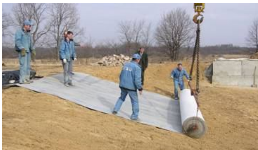
Рисунок 1 – Гидроизоляция полигона твердых бытовых отходов с использованием бентоматов
