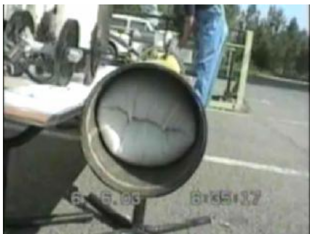
Рисунок 7 – Введение рукава в трубопровод
