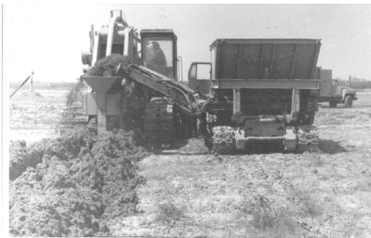
Рисунок 2 - Технологическая операция укладки гофрированной, перфорированной трубы с обсыпкой её ПГС
