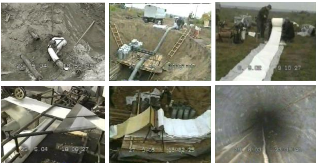
Рисунок 8 - Фрагменты восстановления трубопроводов
