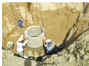
Рис.11. Монтаж секций верхних частей колодцев
