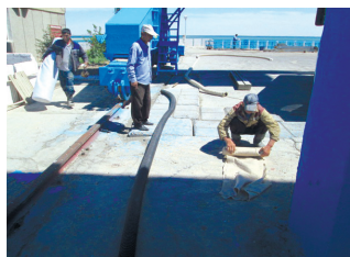
Рис.7. Подготовка гофрированных пластмассовых труб к монтажу
