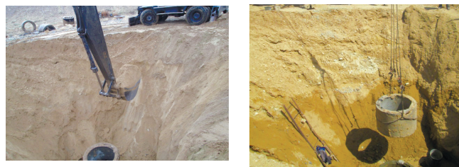
Рис.3. Разработка грунта вокруг смотровых колодцев К 20 и К 20 а экскаватором
