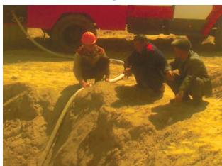
Рис.5. Промывка существующей трубы дренажа с помощью пожарной машины
