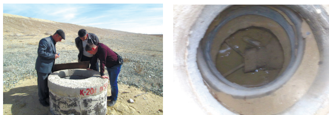
Рис. 2. Смотровые колодцы К 20 и К 20 а с заглушенными деревянными пробками дренажными трубами
