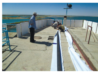
Рис.8. Процесс обертки ЗФМ (геотекстиль) гофрированных пластмассовых труб
