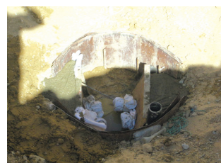
Рис.10. Бетонирование входных и выходных частей старой трубы после введения пластмассовых труб
