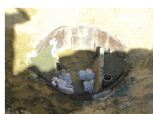
Рис.12. Снятие временных заглушек и работа нового дренажа
