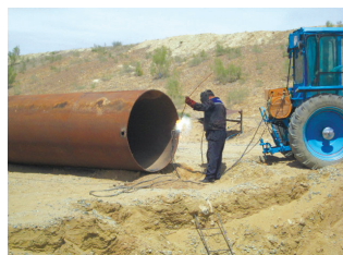
Рис.6. Строительство дополнительного смотрового колодца К 20 б
