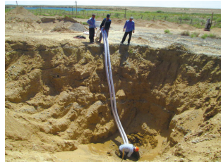
Рис.9. Производство работ по протаскиванию гофрированных пластмассовых труб во внутрь существующей асбоцементной трубы
