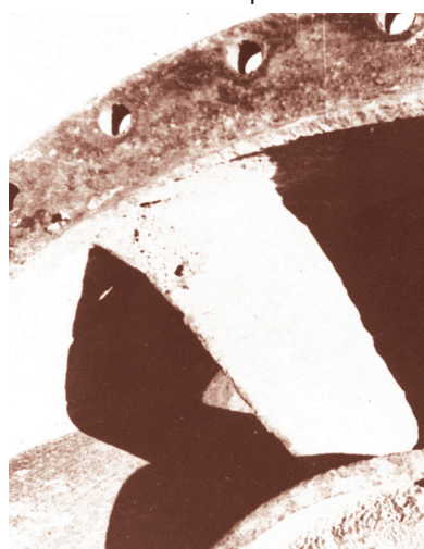
Рис. 6. Повреждение выправляющего аппарата насоса ОП10-185 НС «Куюмазар» после 6100 часов работы
