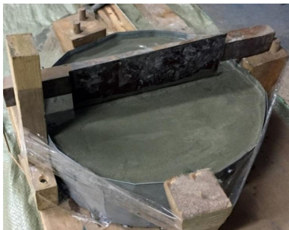
Рисунок 2 – Наполнение цементно-песчаным раствором формы испытываемого образца бетона для облицовки (автор фото А. Ю. Гарбуз)
