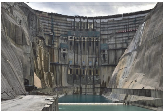
Рис. 5. Фото гидроузла Цзинь Пин с арочной бетонной плотиной
