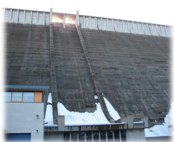
Современная плотина Лейбис-Лихте
