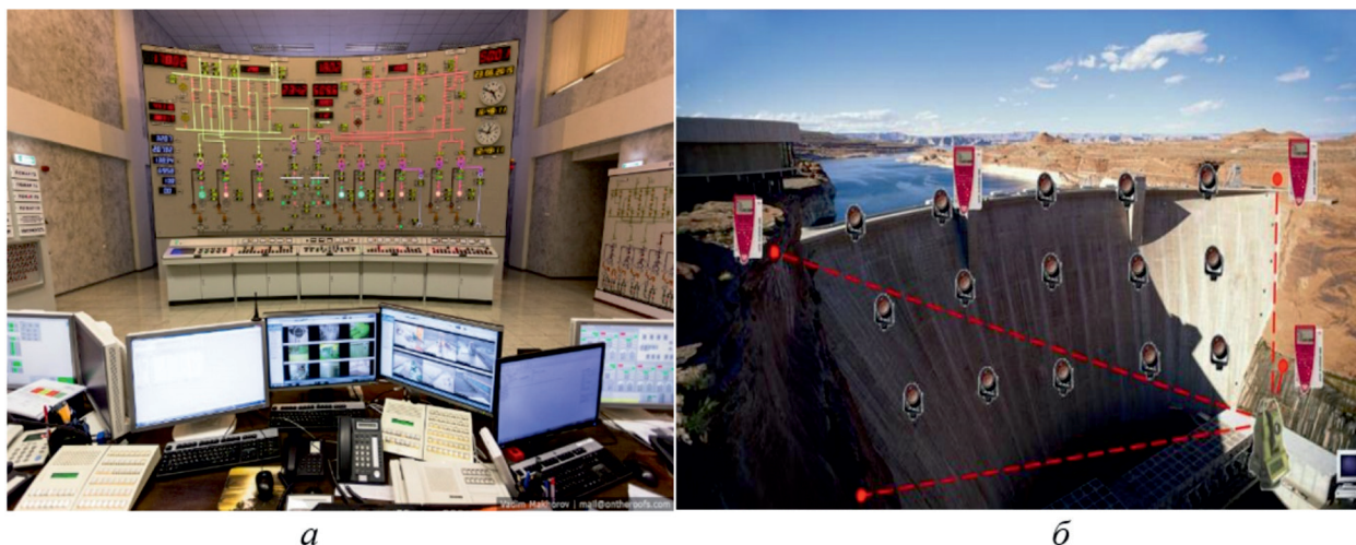
Рис. 1. Пульт управления Богучанской ГЭС (а) и размещение КИА в плотине Чиркейской ГЭС (б)
