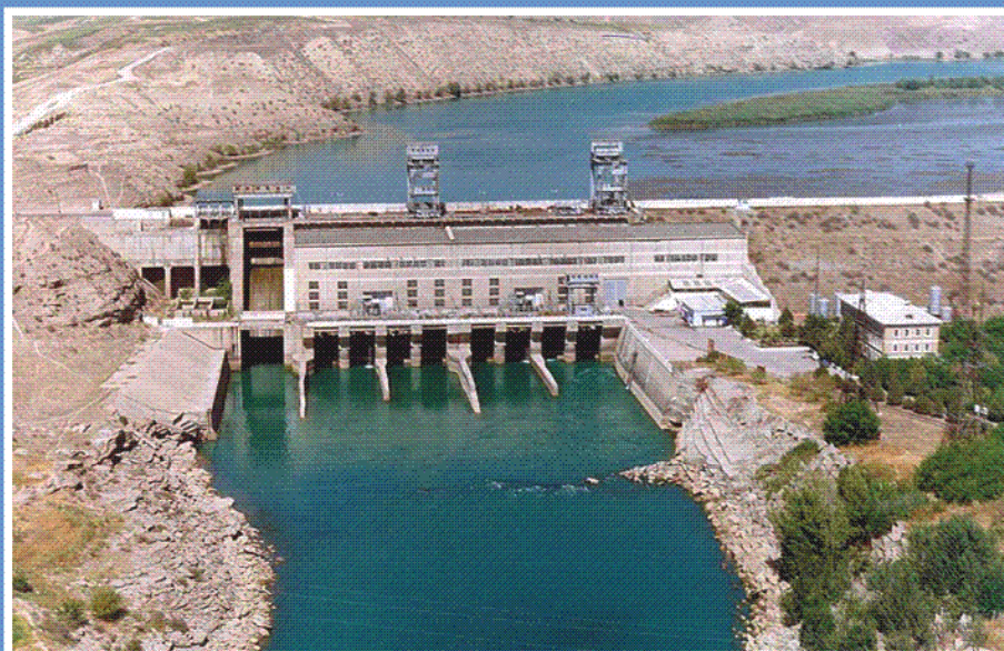
Рис. 8. Плотина Уч-Курганского гидроузла на реке Нарын, Кыргызстан (высота плотины - 36 м; объем водохранилища - 56,4 млн.м 3 )
