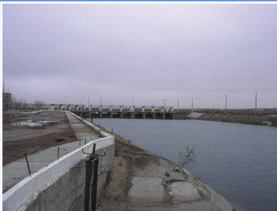
Рис. 14. Огузханский гидроузел на Каракум-реке, Туркменистан (высота плотины - 15 м; объем водохранилища - 700 млн.м 3 )
