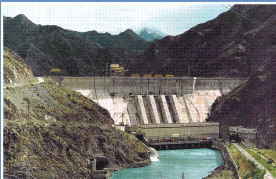
Рис. 9. Плотина Курпсайского гидроузла на реке Нарын, Кыргызстан (высота плотины - 113 м; объем водохранилища - 370 млн.м 3 )
