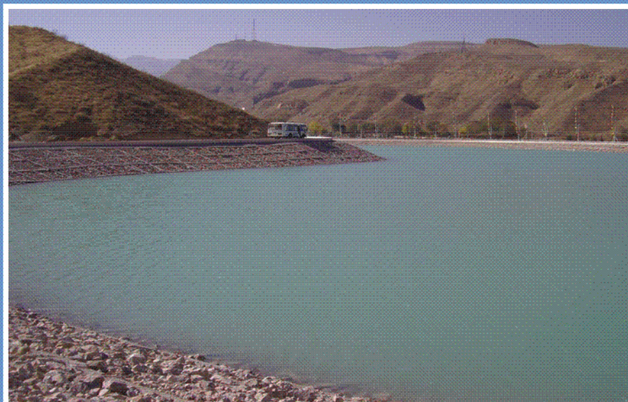
Рис. 13. Пулихатунский гидроузел на реке Теджен, Туркменистан (высота плотины "Достлук" - 78 м; объем водохранилища - 1250 млн.м 3 )
