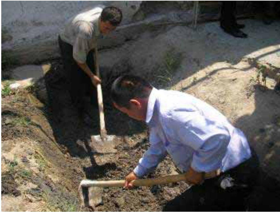
Рис.1.7 Очистка дна канала от ила и водной растительности
