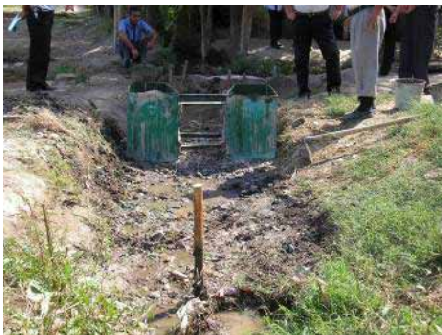
Рис.1.9 Установка металлической опалубки для лотка САНИИРИ по оси участка канала
