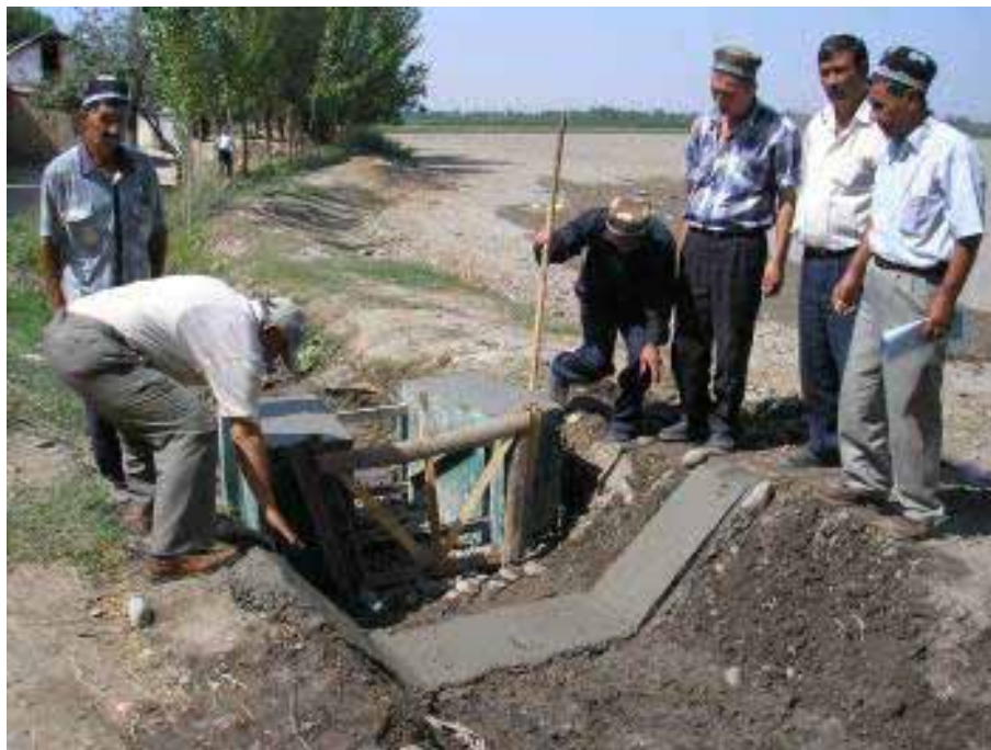
Рис.1.10 Часть бетонной облицовки подводящего русла гидрометрического поста с лотком САНИИРИ
