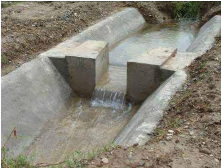
Рис.1.6 Гидростат с ВЛС, вид с нижнего бьефа
