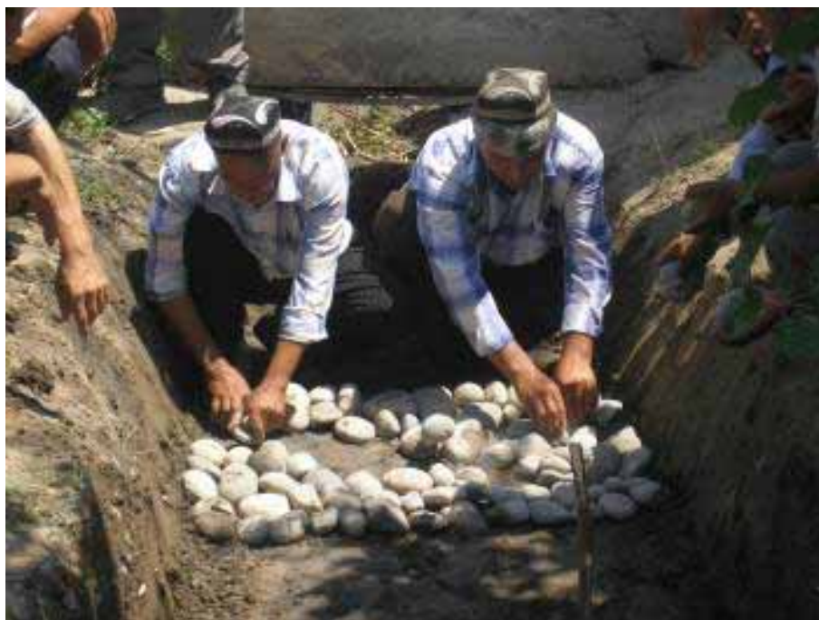
Рис.1.8 Укладка каменной наброски под основание водомерного устройства
