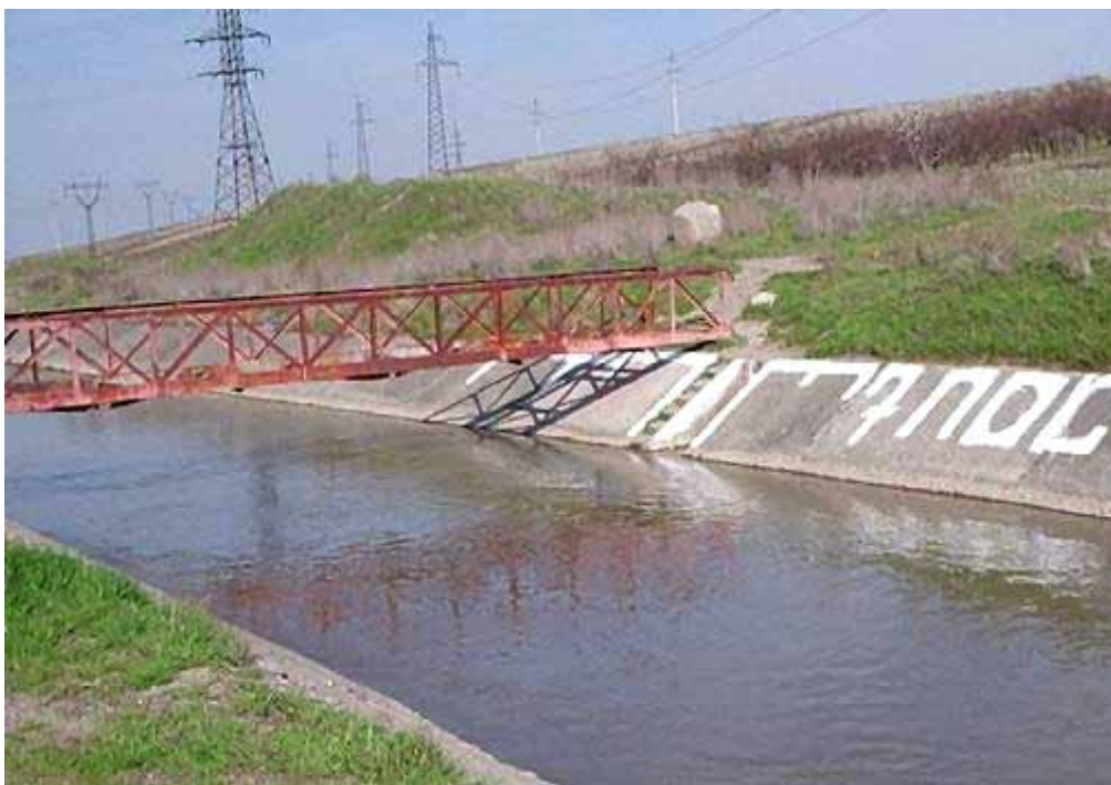
Гидропост на магистральном канале (ЮФМК)
