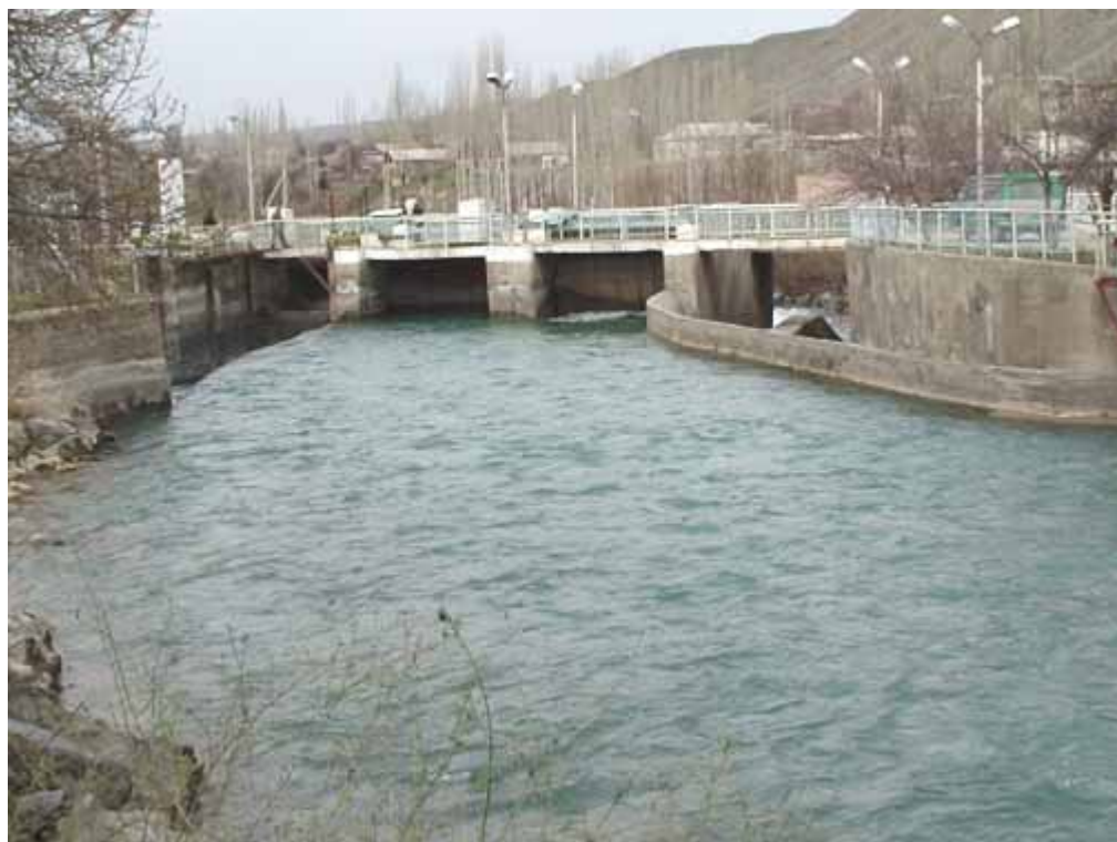
Головное сооружение ААК
