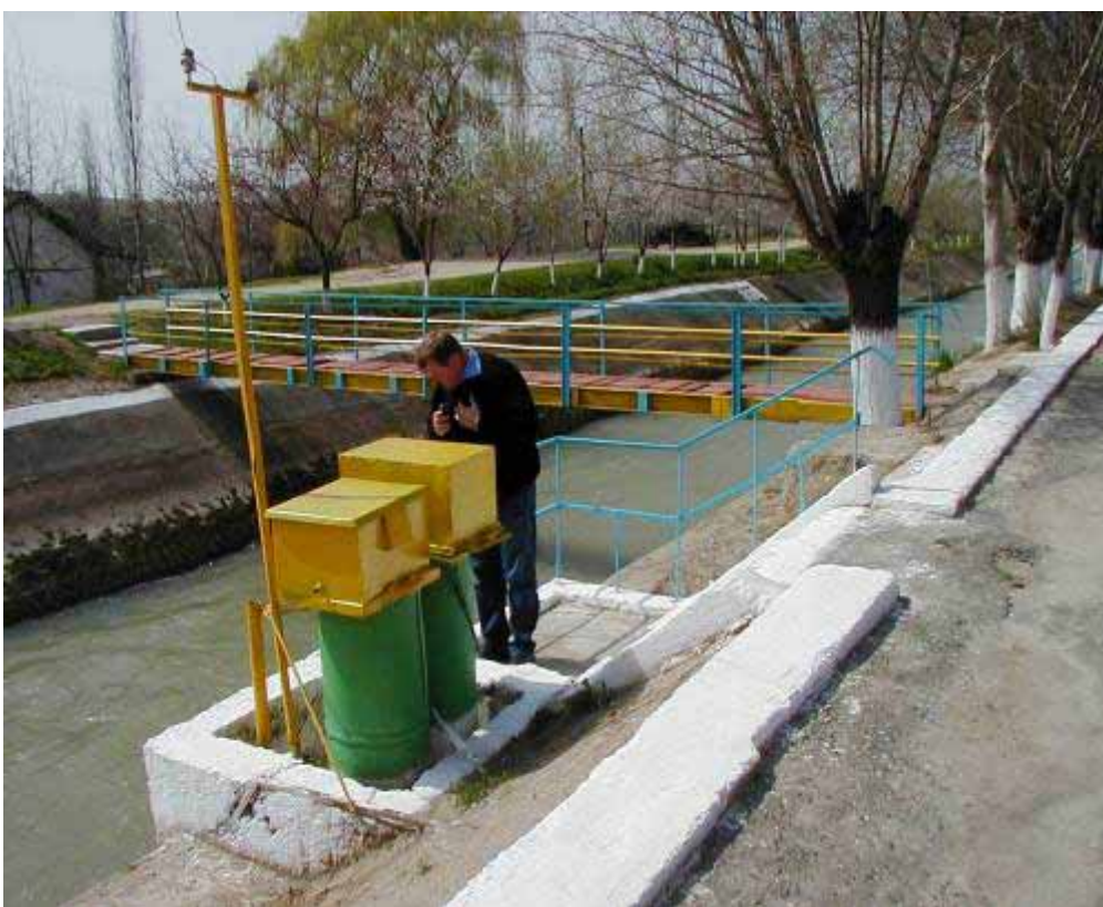
Гидроучасток «Палванташ» (ЮФМК)
