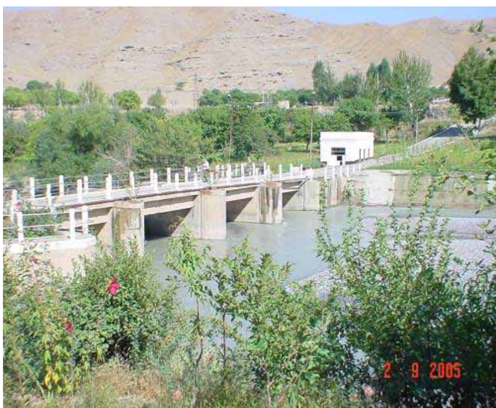
Плотина на реке Ходжабакиргансай
